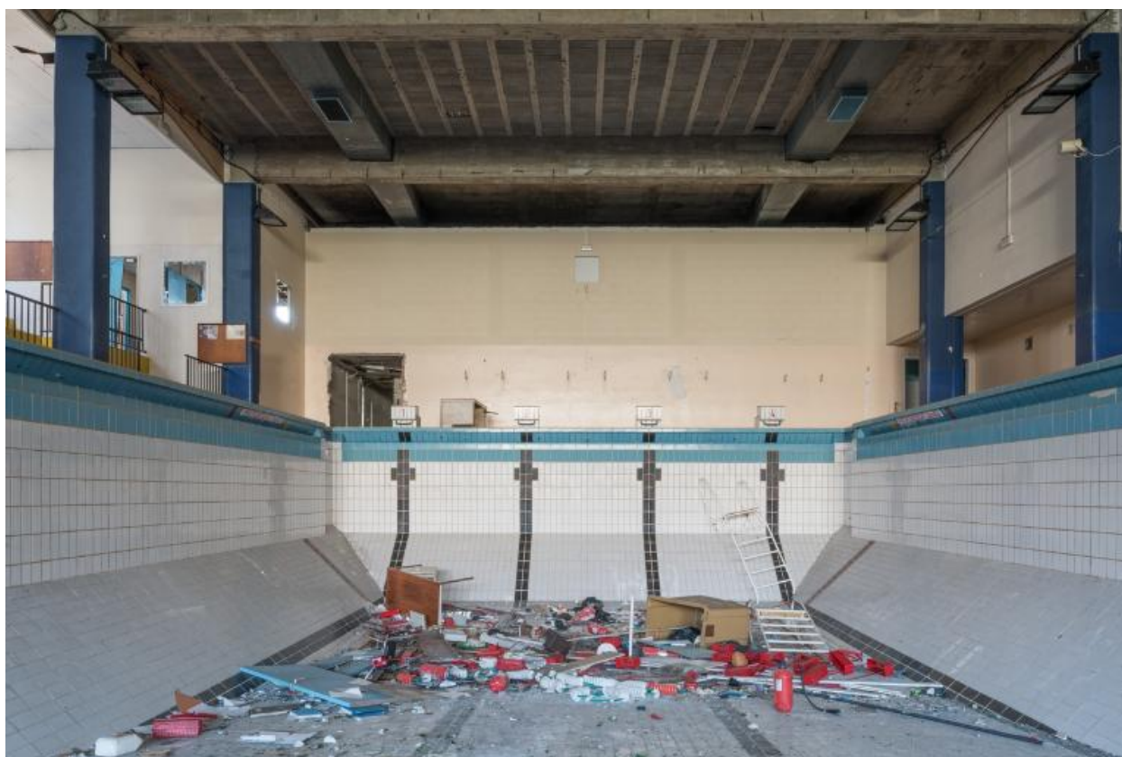
Vue prise dans l'axe du grand bassin désaffecté, en 2019. Jean de Jaegher et François Rousseau, architectes, 1968.
