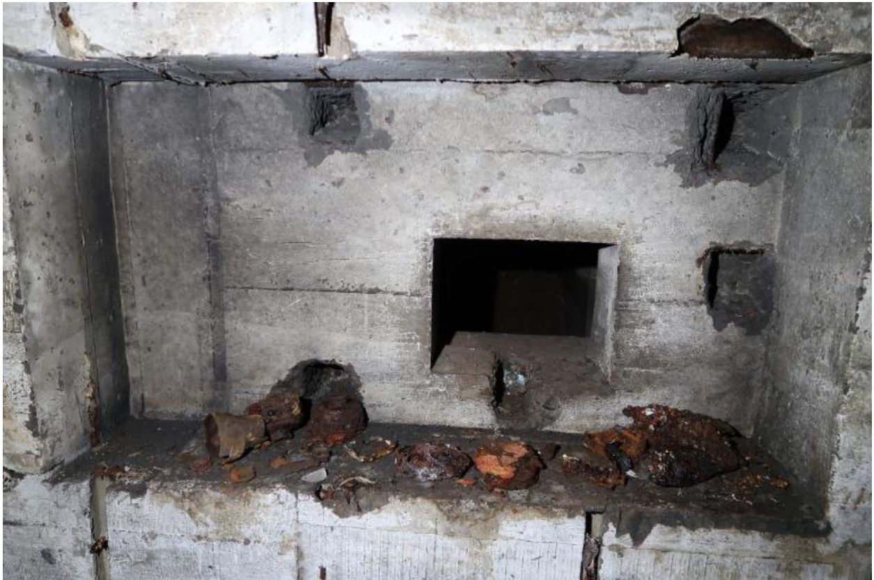
Vue intérieure : salle de garde sud avec créneau blindé [non posé]
