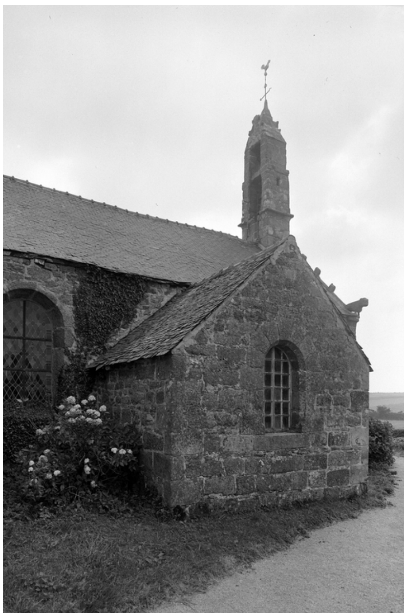
Façade nord : détail de la chapelle des Fonts baptismaux
