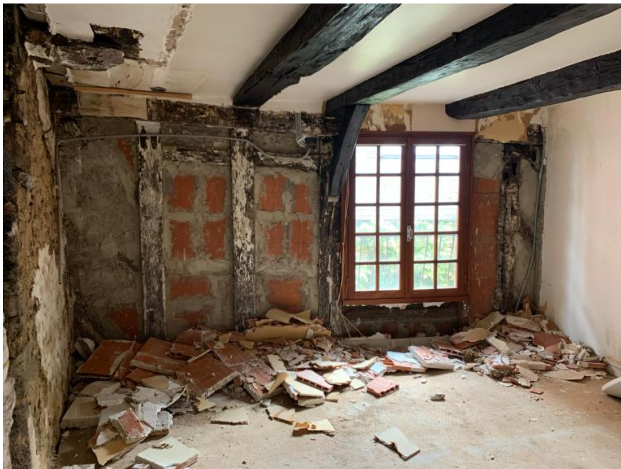
Maison à gauche. Premier étage
