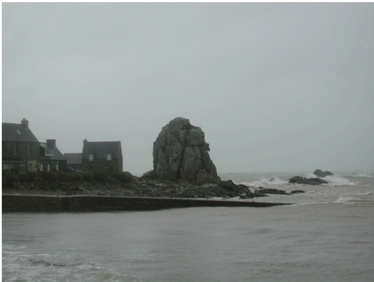
Vue de la cale de Pors Hir, à mi marée, un jour de tempête (mars 2008)
