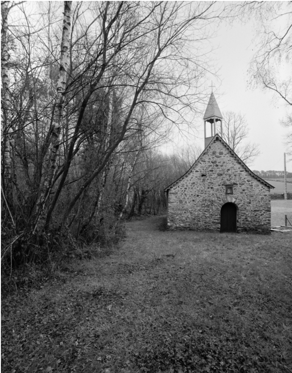
Vue générale ouest
