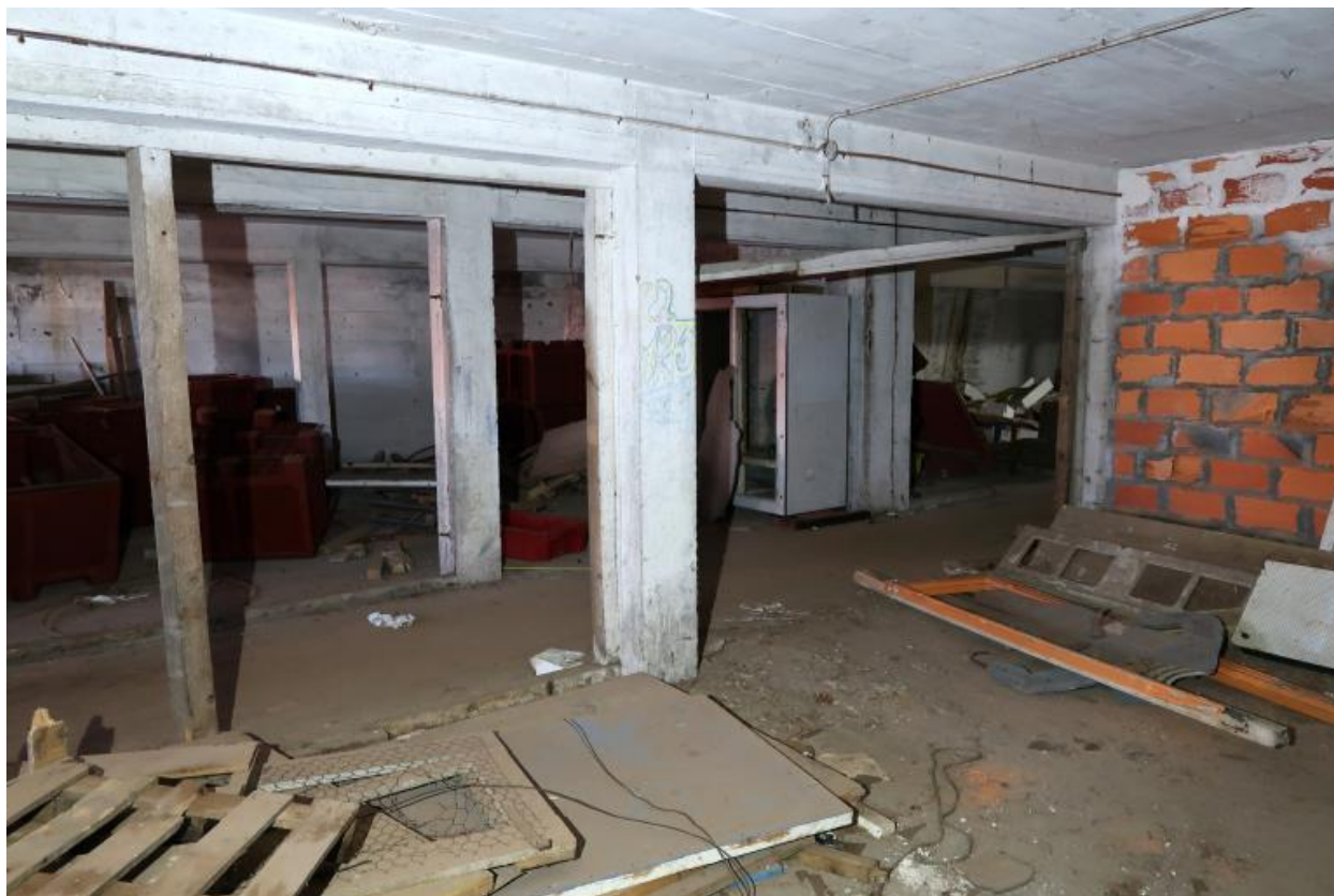
Premier étage : extrémité nord, marquage "U 123" (box 28)
