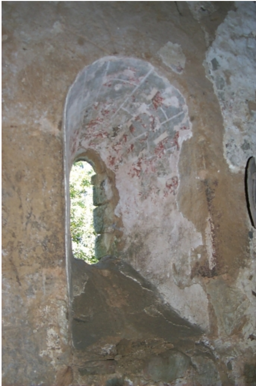
Intérieur, mur nord, baie romane avec des traces d'enduit peint en faux appareillage
