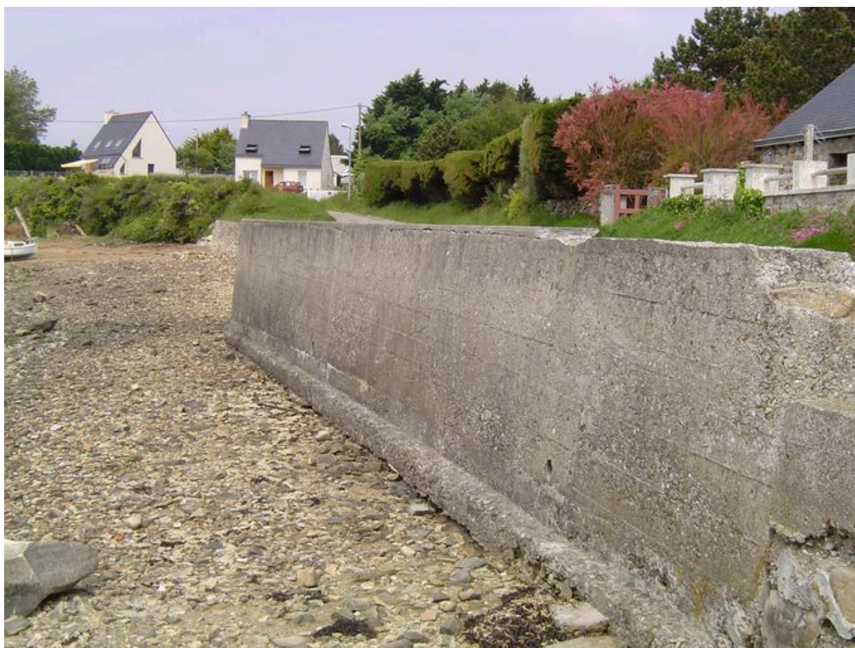
Digue du du front de mer de Rostellec
