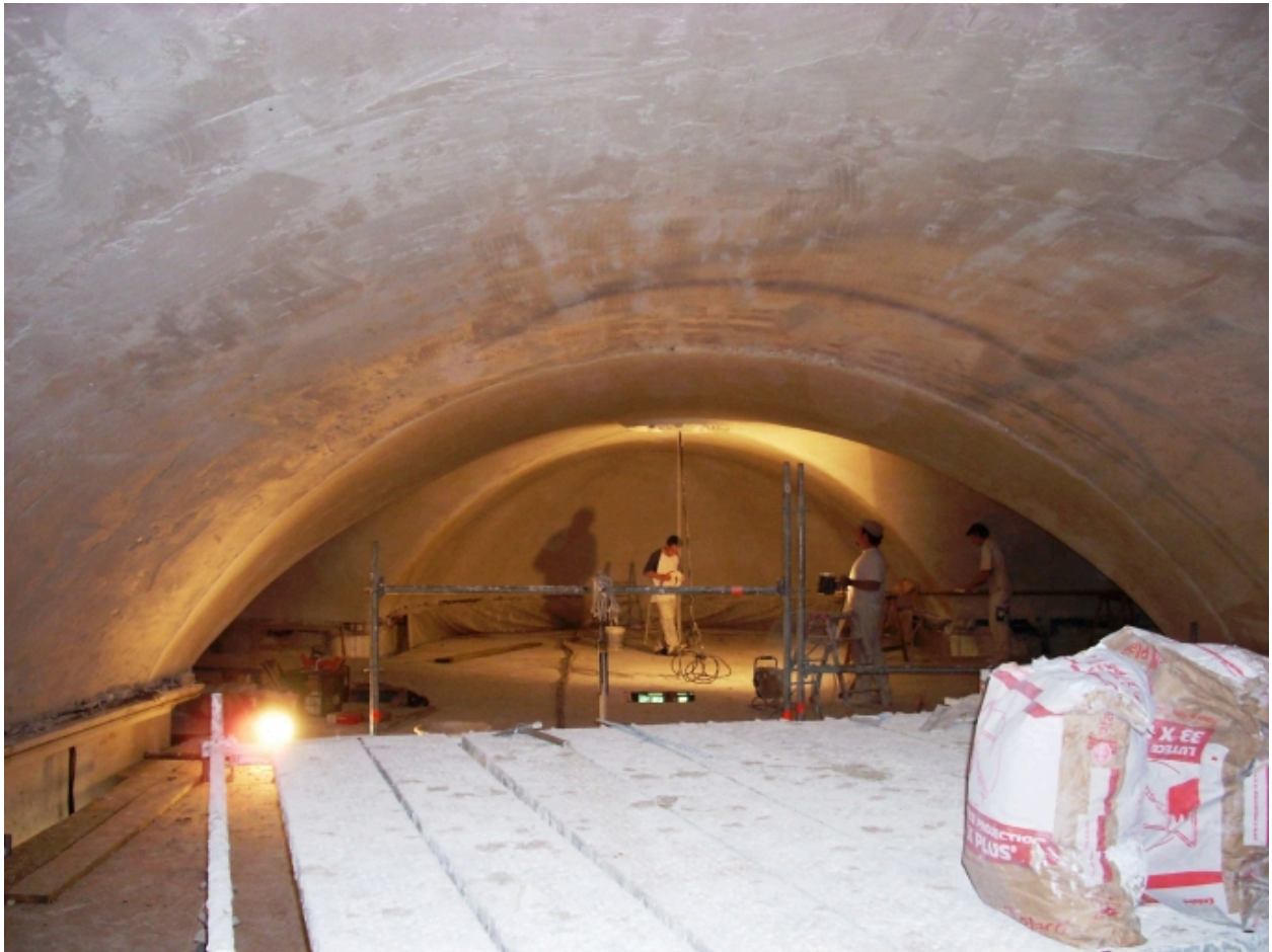
Le Ponthou, église paroissiale Saint-Barthélémy : vue transversale sud-est de la fausse voûte, détail
