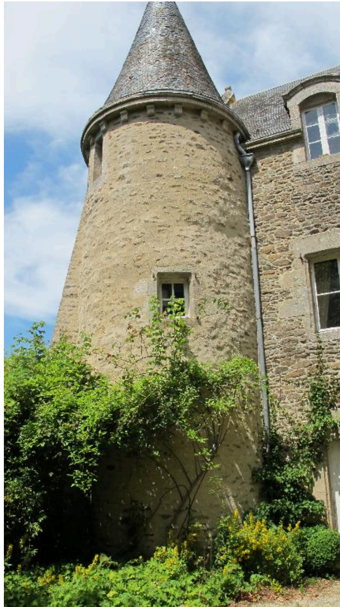
Pavillon originel sur la Rance avec tour d'angle, vue prise de l'ouest
