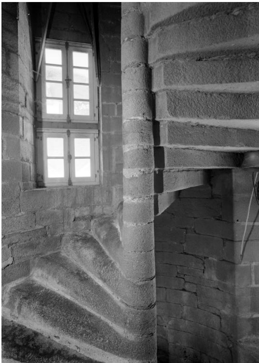
Escalier à vis dans la tour du sud-ouest
