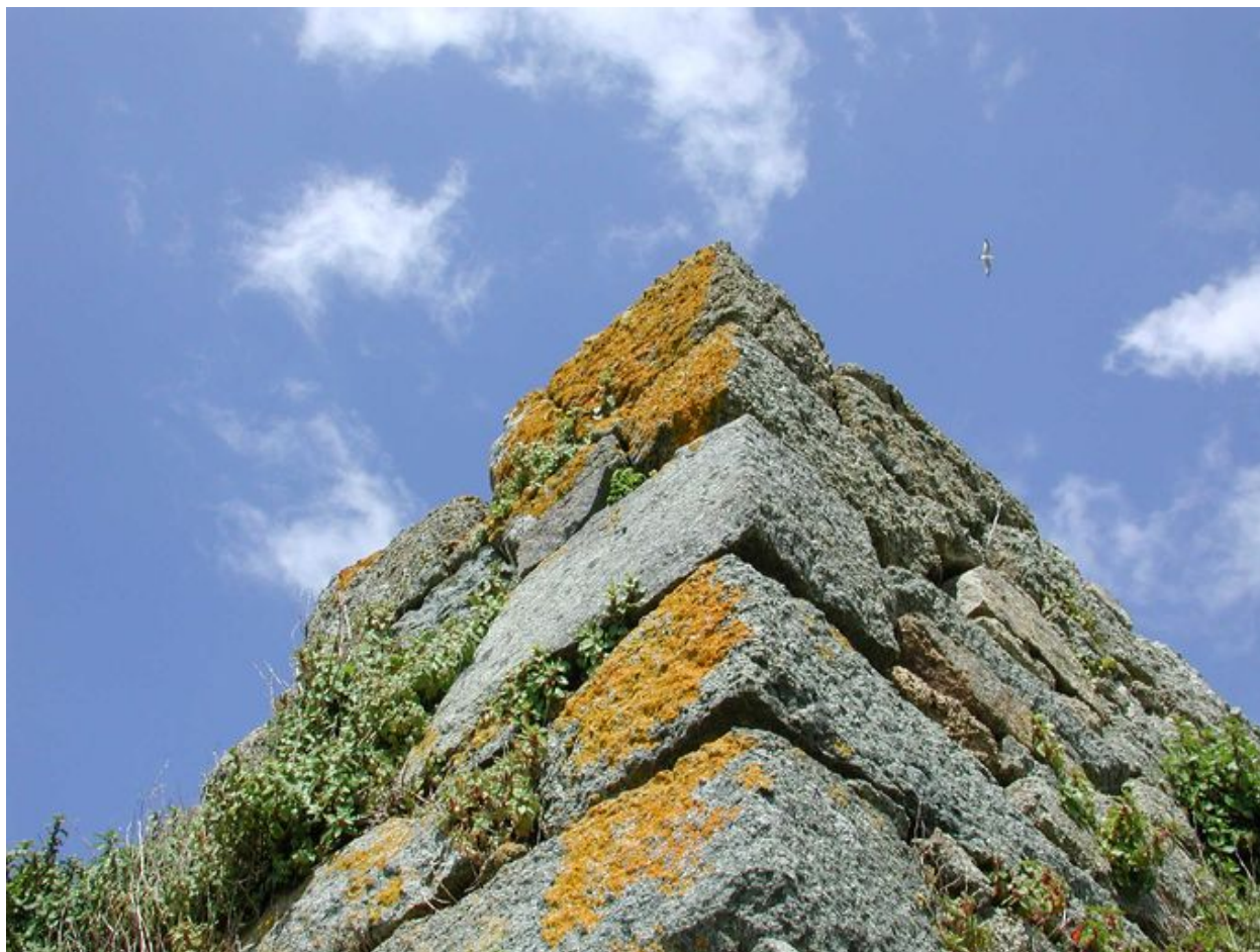
Vue de détail : maçonnerie de moellon de granite (état en 2002)
