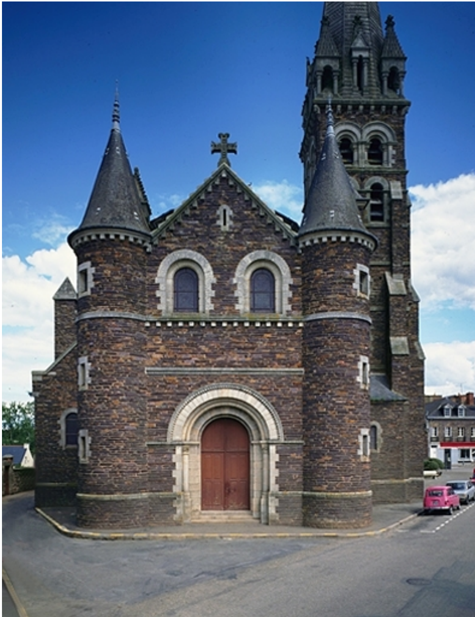
Le porche occidental : vue générale
