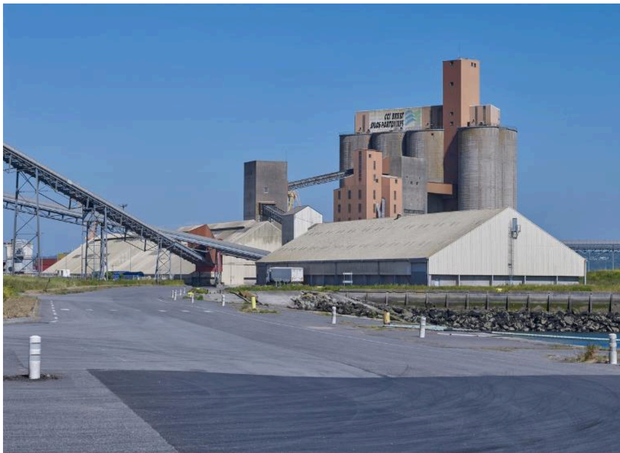
Vue d'ensemble des silos, bandes transporteuses, tour de liaison et entrepôts
