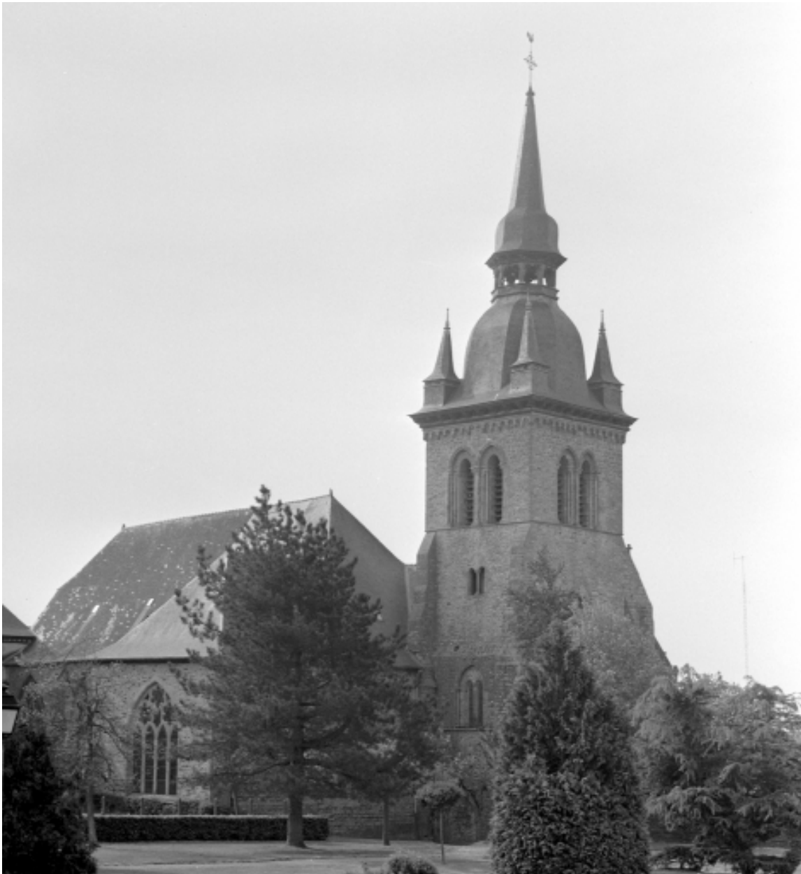
Elévation Nord-Ouest : vue générale
