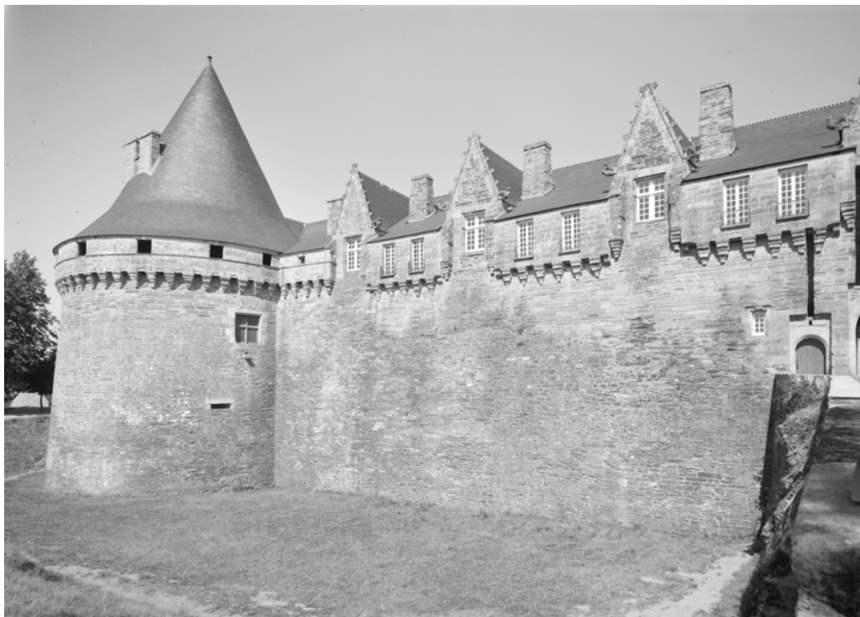
Aile nord et tour nord-ouest.
