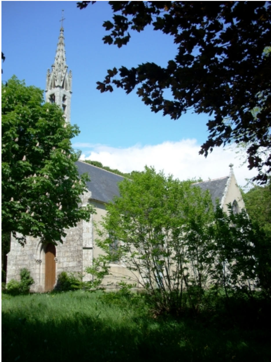
Plogonnec, chapelle Notre-Dame-de-Lorette : vue générale sud-ouest
