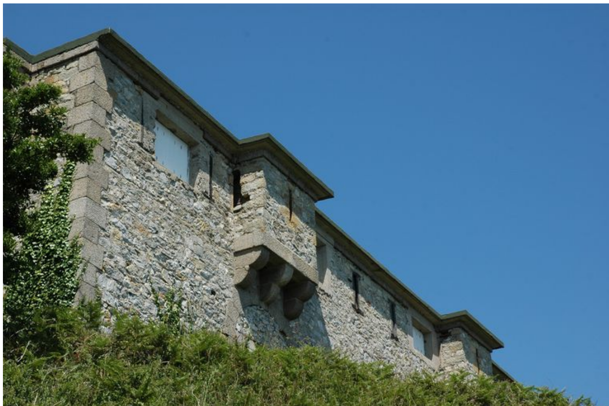
Vue du corps de garde crénelé : mur oriental (état en 2005)
