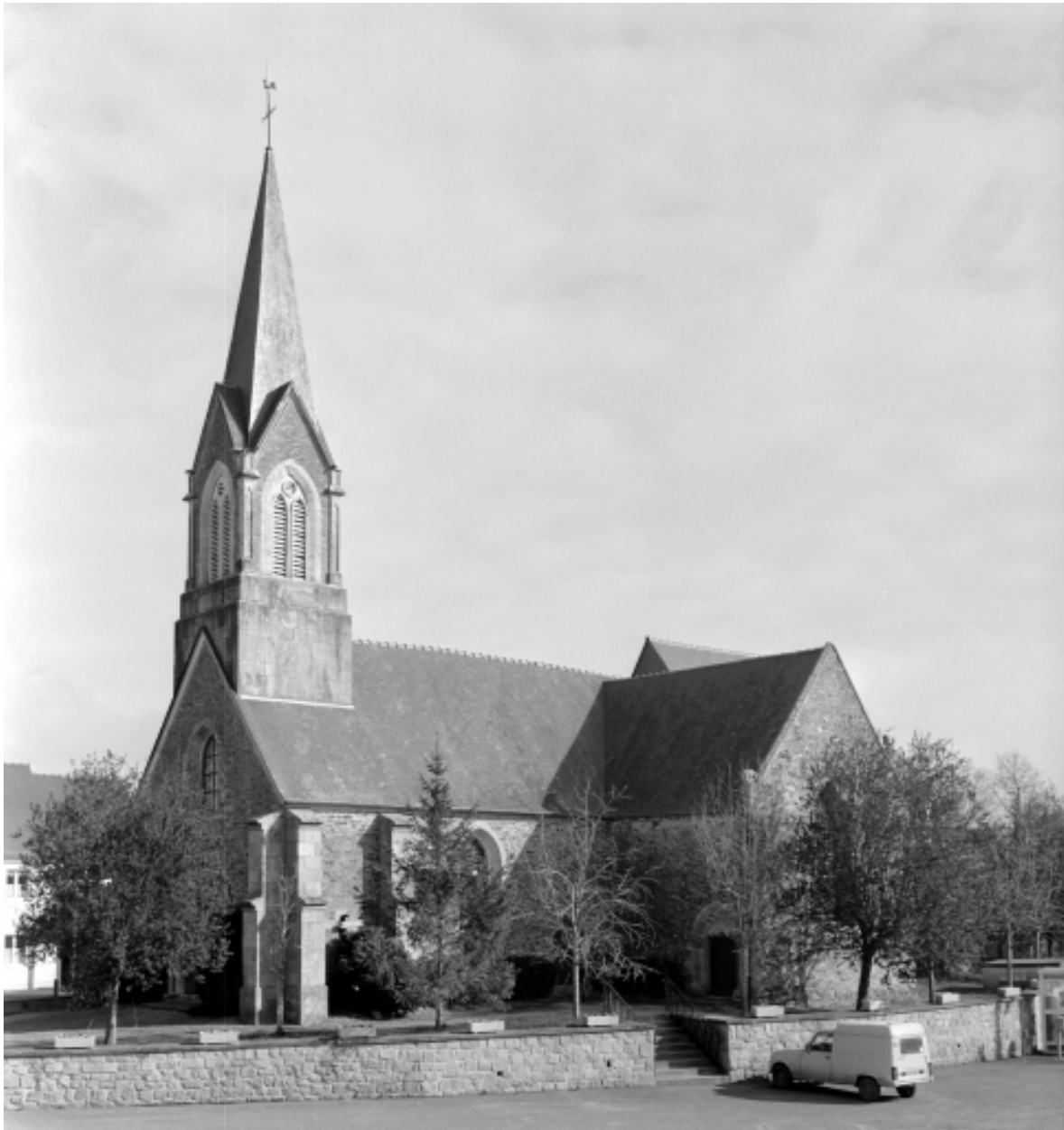
Elévation Sud-Ouest : vue générale
