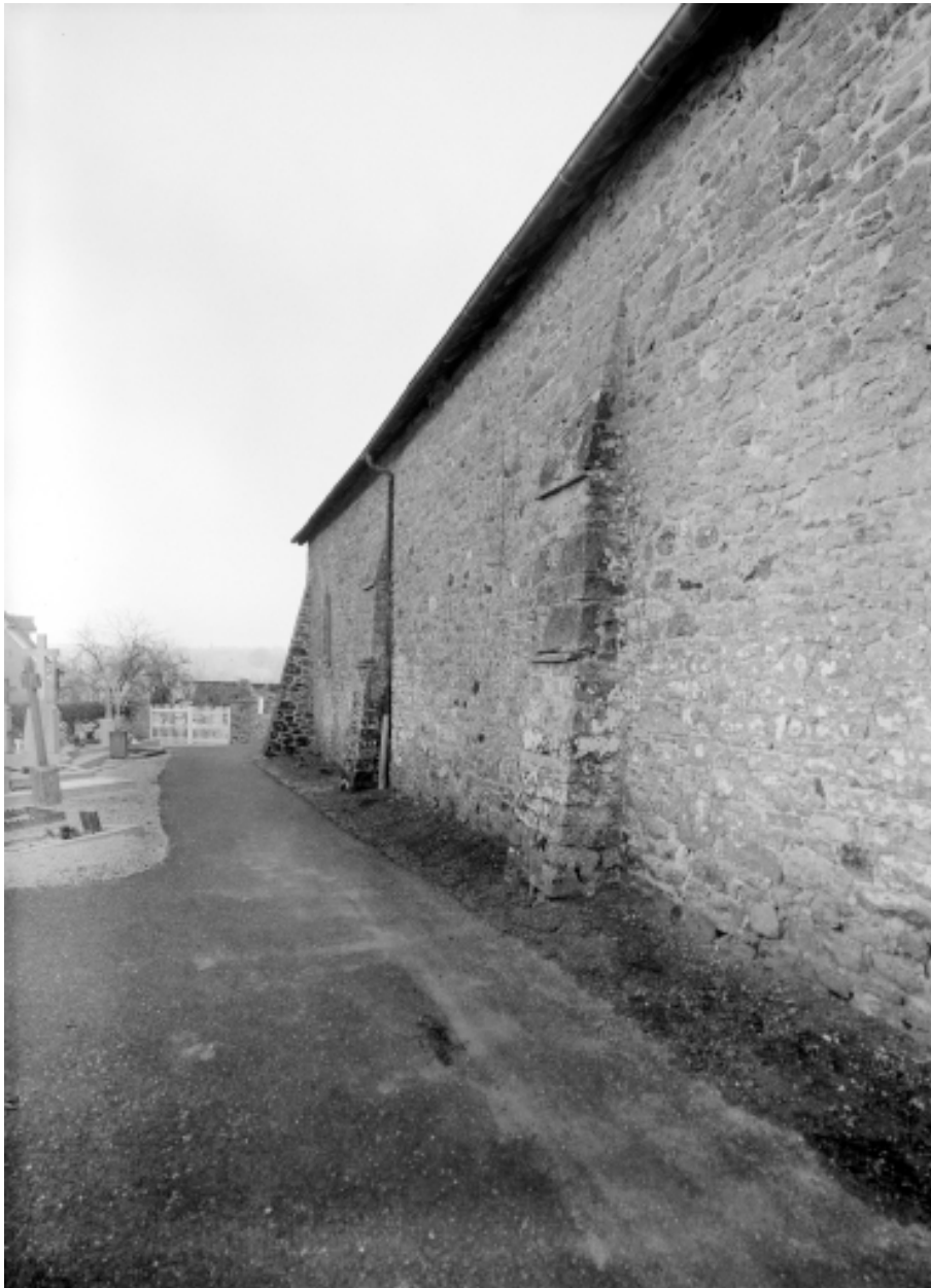
Elévation nord, partie centrale : détail de l'alignement
