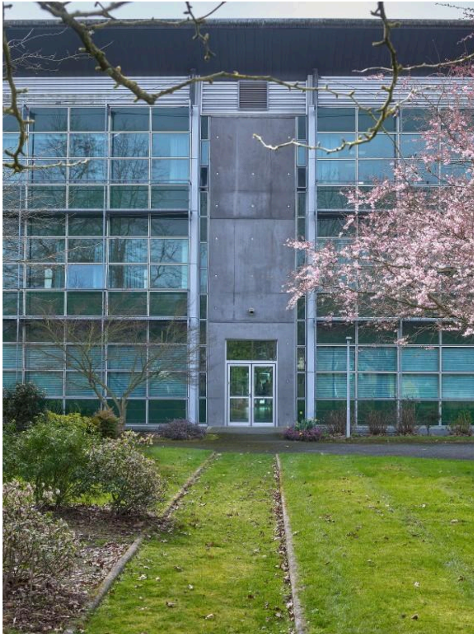
Façade nord du bâtiment principal. Détail sur la travée d'un accès secondaire. Joël Y. Gautier, architecte, 1992.
