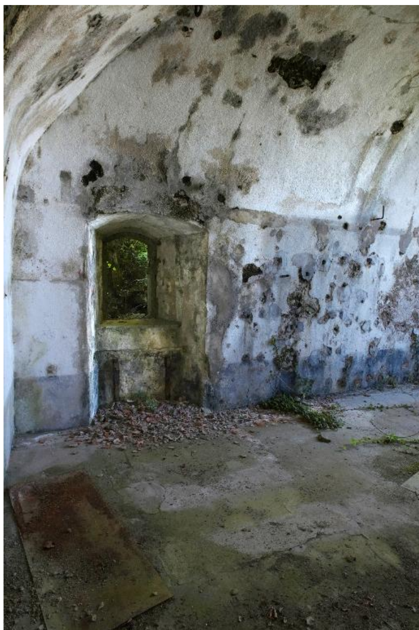
Plouzané : vue du fort du Mengant, usine électrique aménagée à flanc de falaise, intérieur, enduit
