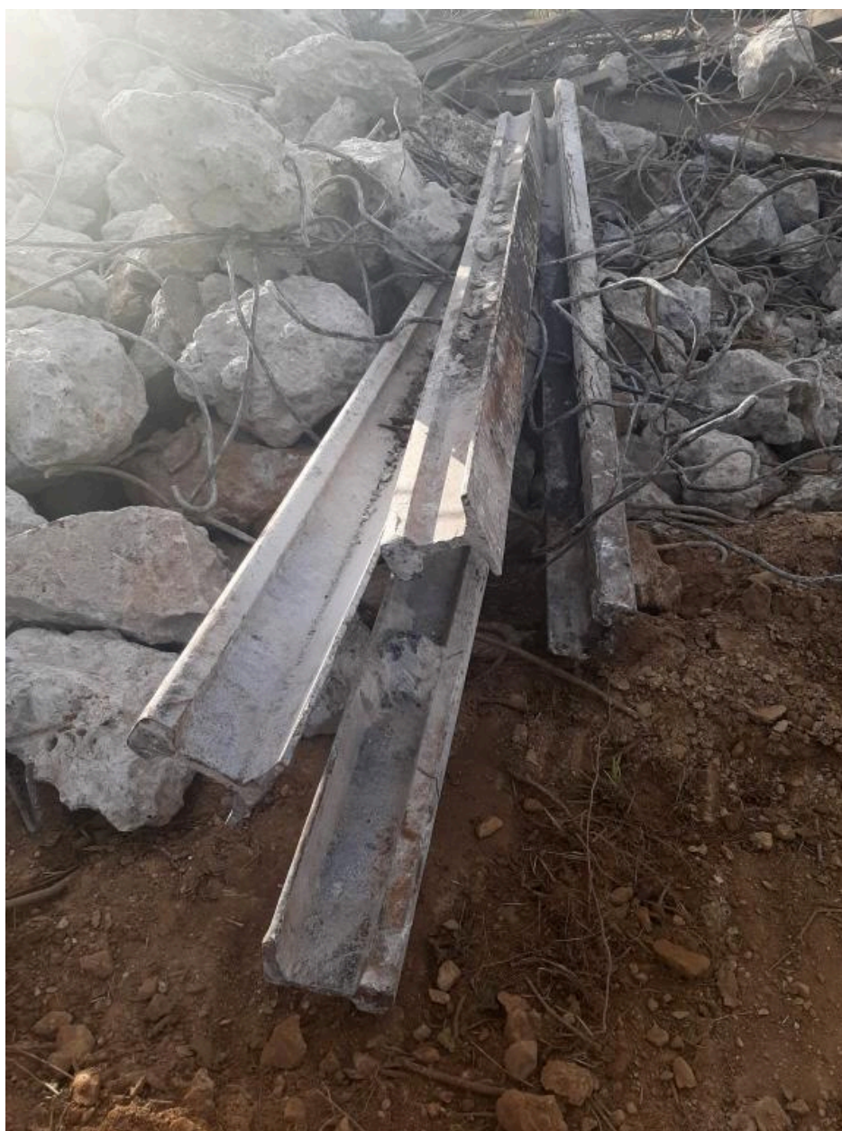
Vue de la déconstruction (26 septembre 2022). Au premier plan : blocs de béton et rails de chemin de fer
