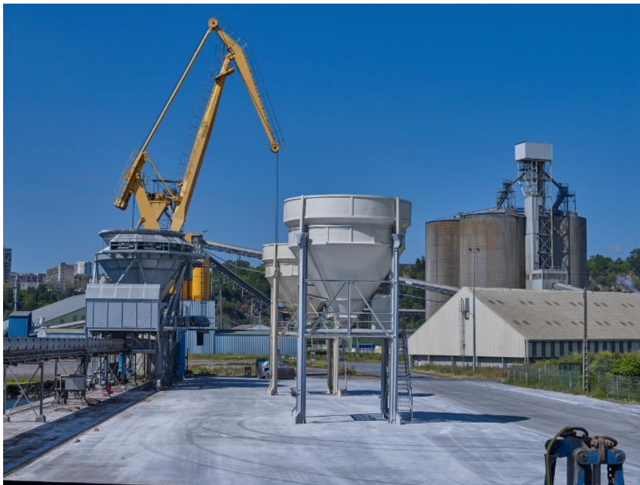
Magasin de stockage, trémies, grue, bandes transporteuses, tour de liaison, silos
