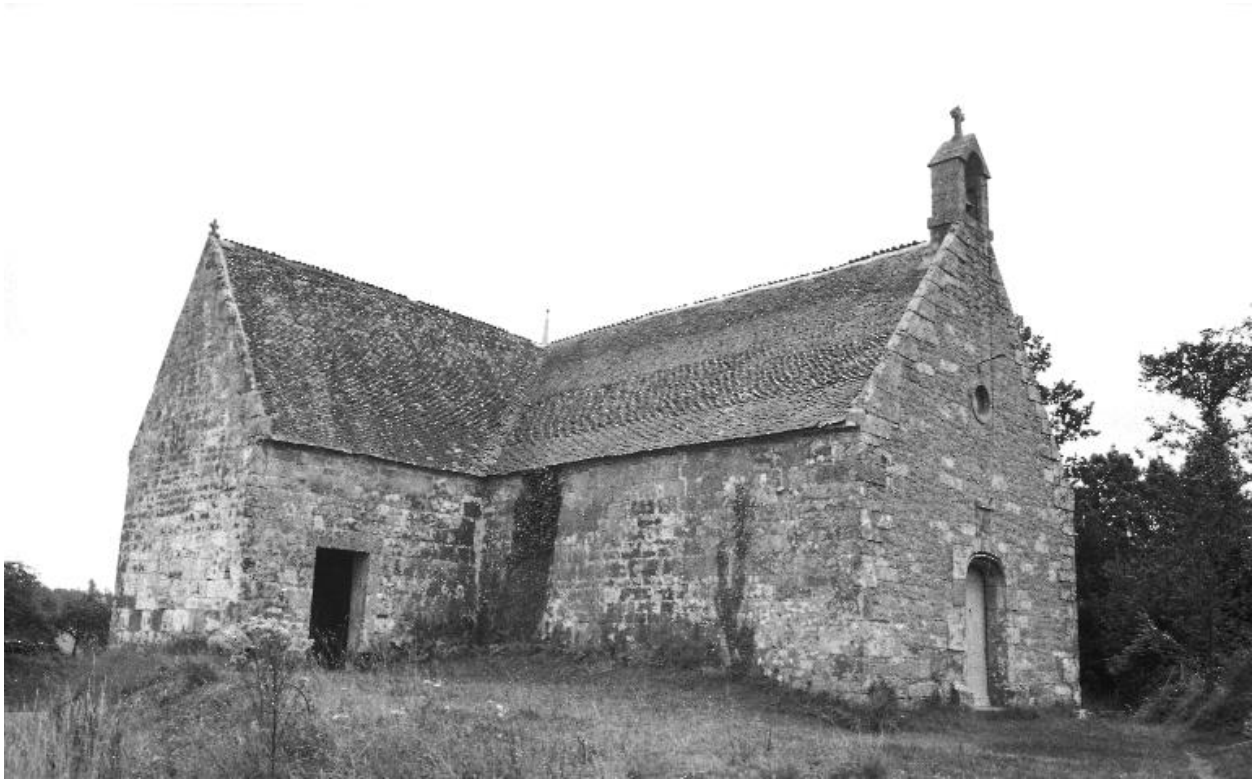
Vue d'ensemble prise du nord-ouest
