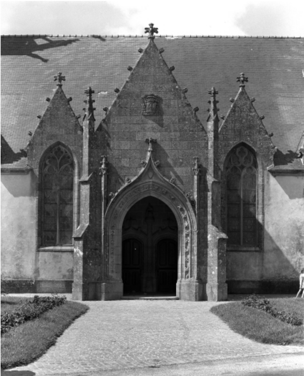
Plonévez-Porzay, église paroissiale Saint-Miliau : façade sud, détail du porche, état en 1970
