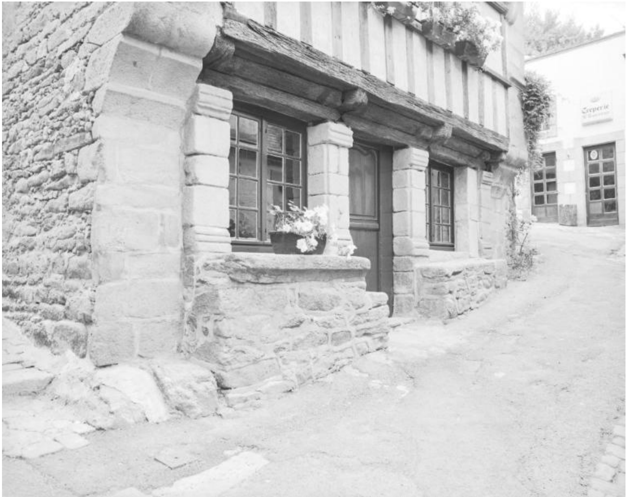
Elévation principale en pan de bois rue Saint-Sauveur, détail façade principale.
