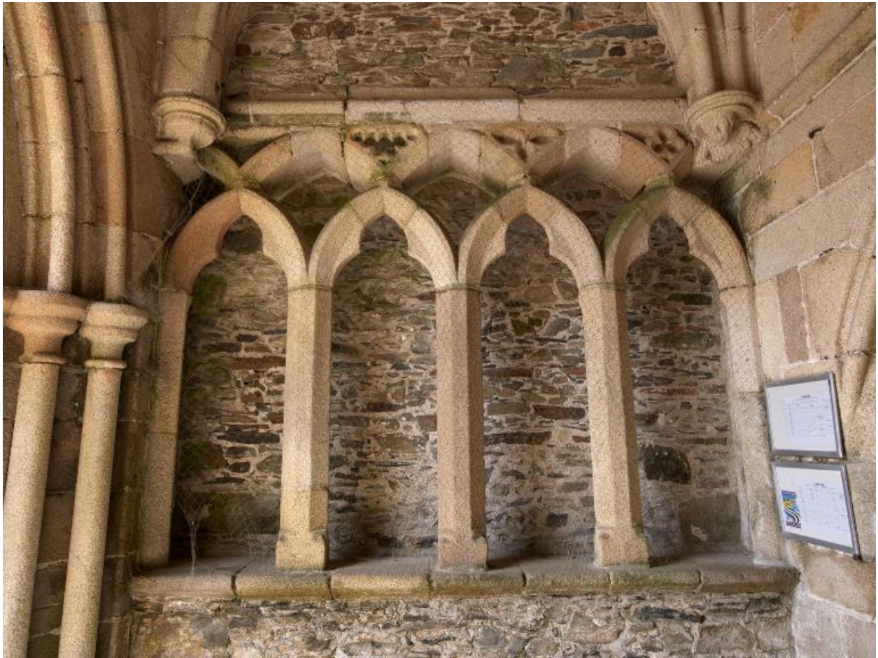
Porche sud. Détail du décor d'arcatures évidées détachées des parois latérales et de la retombée de la voûte sur des culots figurés
