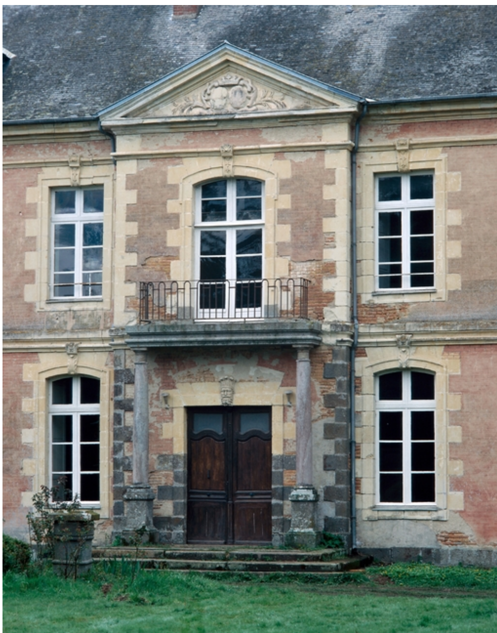
Elévation est, travée centrale.
