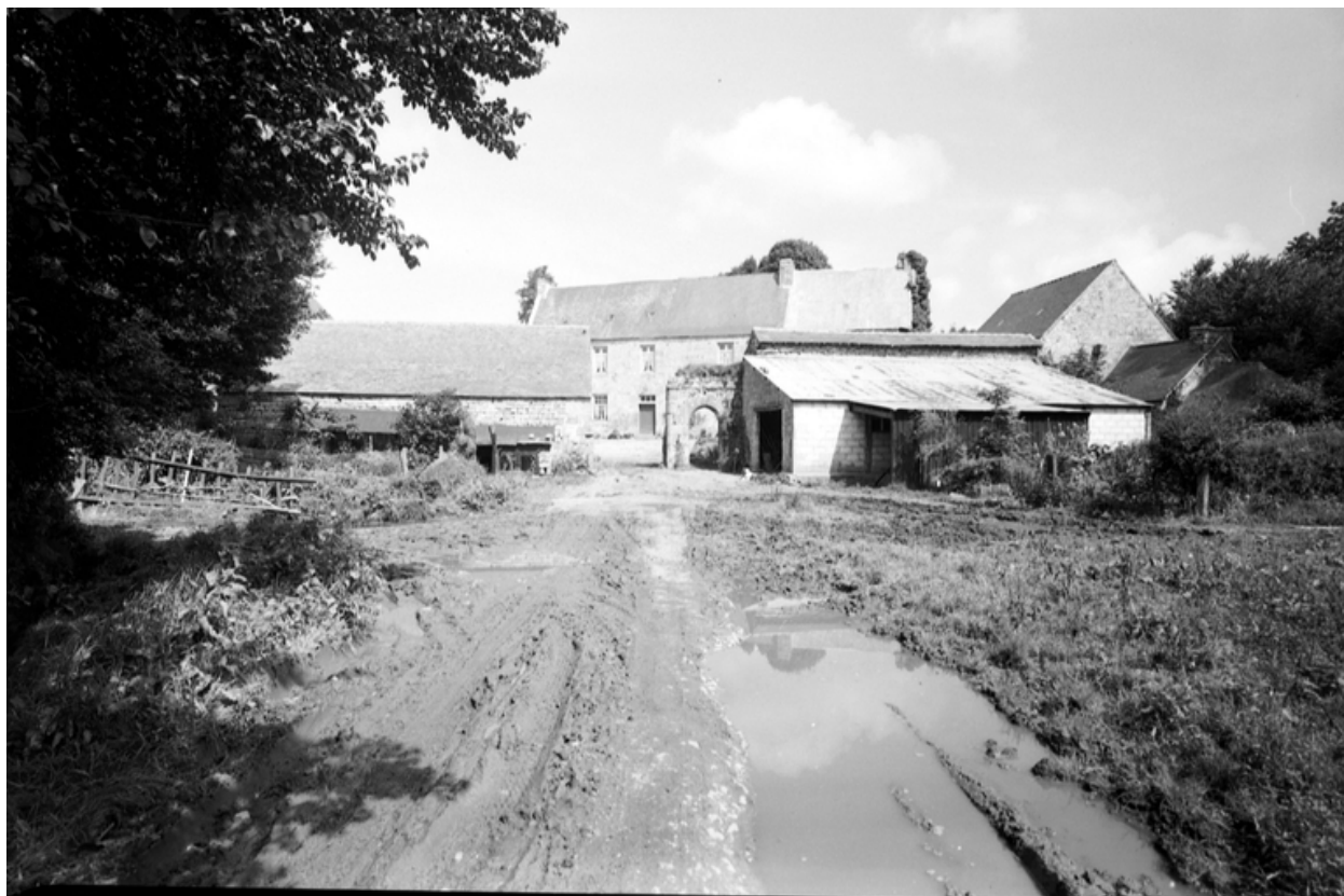
Vue d'ensemble des bâtiments
