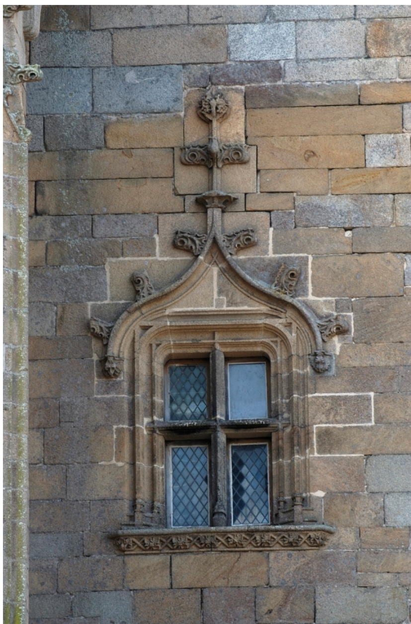
Fenêtre dans la face nord du premier étage de la tour
