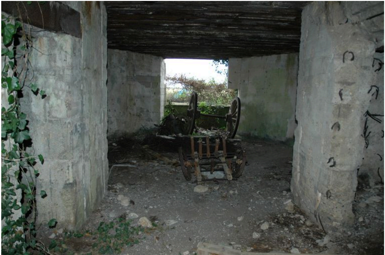
Vue intérieure de l'une des quatre casemates de type 669 (état en 2008). De part et d'autre de l'entrée, les niches à munitions
