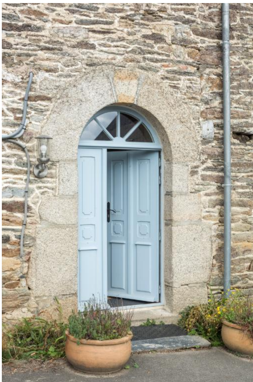
Logis ouest, élévation sud-est, vue générale de la porte d'entrée
