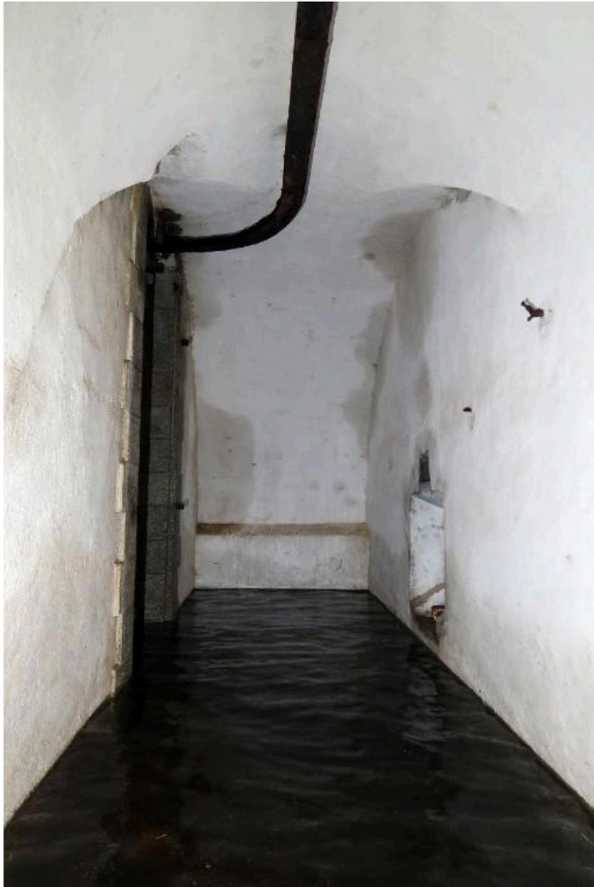
Vue du vestibule côté puits du monte-charge. Suspendu au plafond, le rail permettait la manutention des obus via le treuil. Le magasin est partiellement inondé
