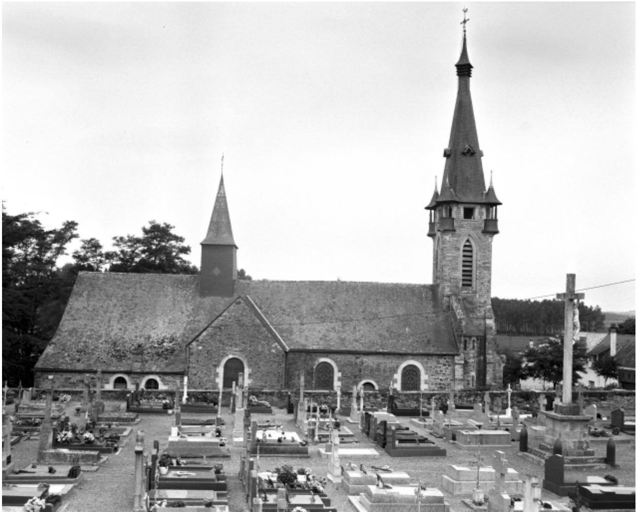
Vue générale nord
