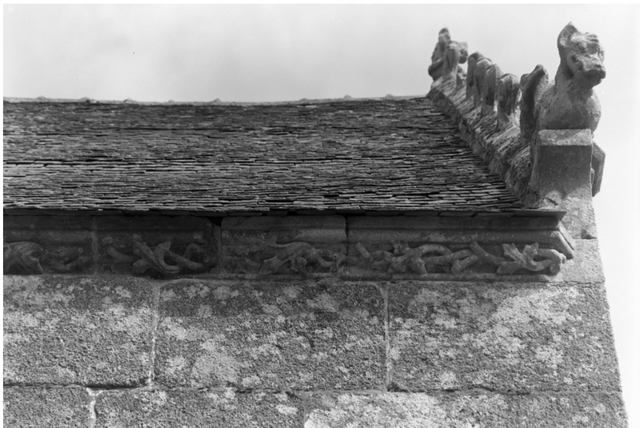
Croisillon occidental sud, face ouest : détail de la partie droite de la corniche
