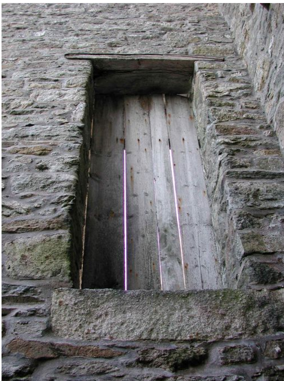
Vue de l'une des demeures situées en front de mer de la rue de l'Amiral-Réveillère : détail du mur de clôture percé d'une porte
