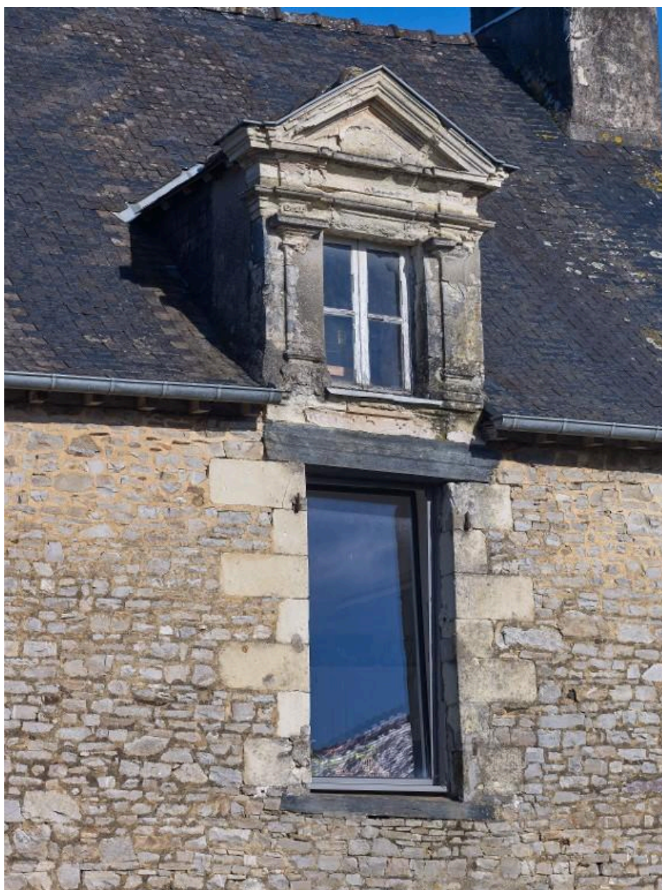
Lucarne d'orgueil du presbytère
