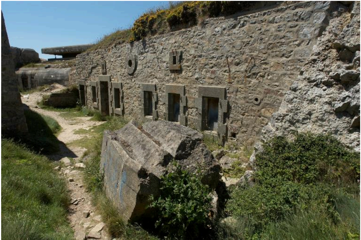
Vue de l'extrémité de la batterie de mortier : abri double sous traverse en maçonnerie
