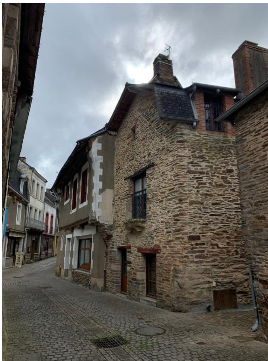
Elévation sud vue depuis l'est
