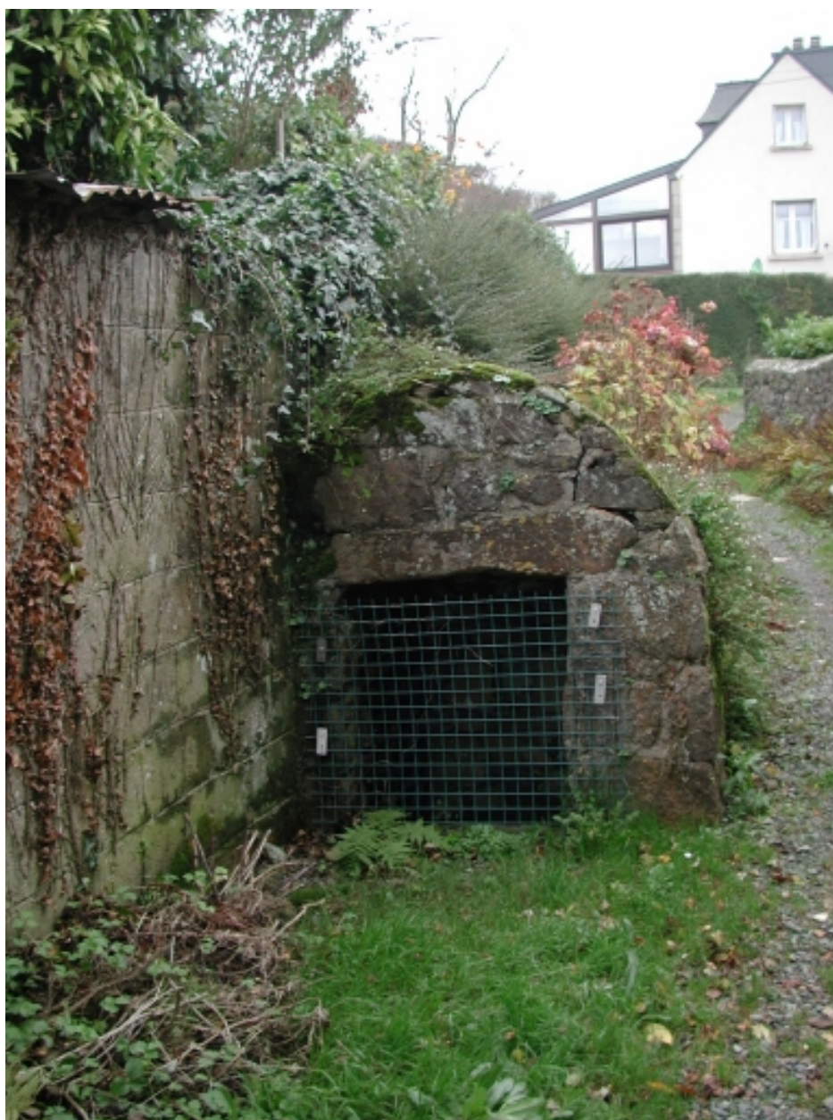
Feunten Coz (baie de Launay) : construction en granite et grès avec une couverture cimentée, datée du 19ème ou 18ème siècle (cours d'eau 'Kerlic')
