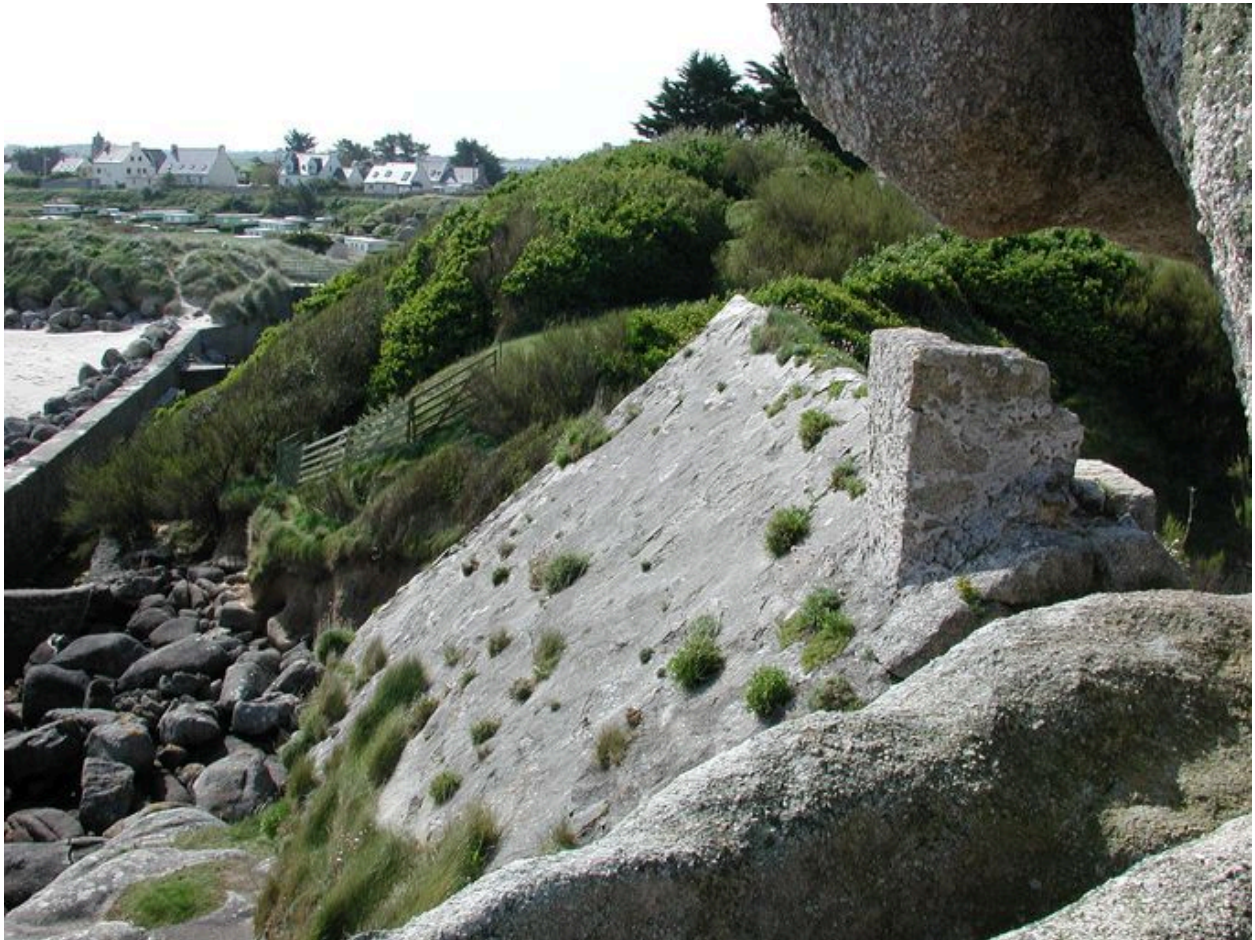
Cléder : vue générale de la couverture en dalles de granite et de la cheminée du corps de garde de Lavillo
