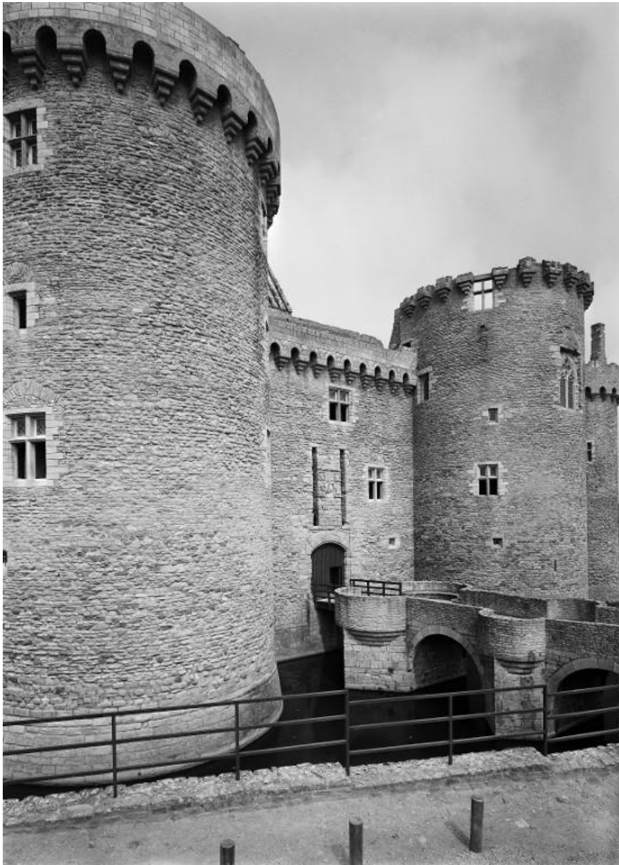
Château fort, logis est et pont, élévation est.
