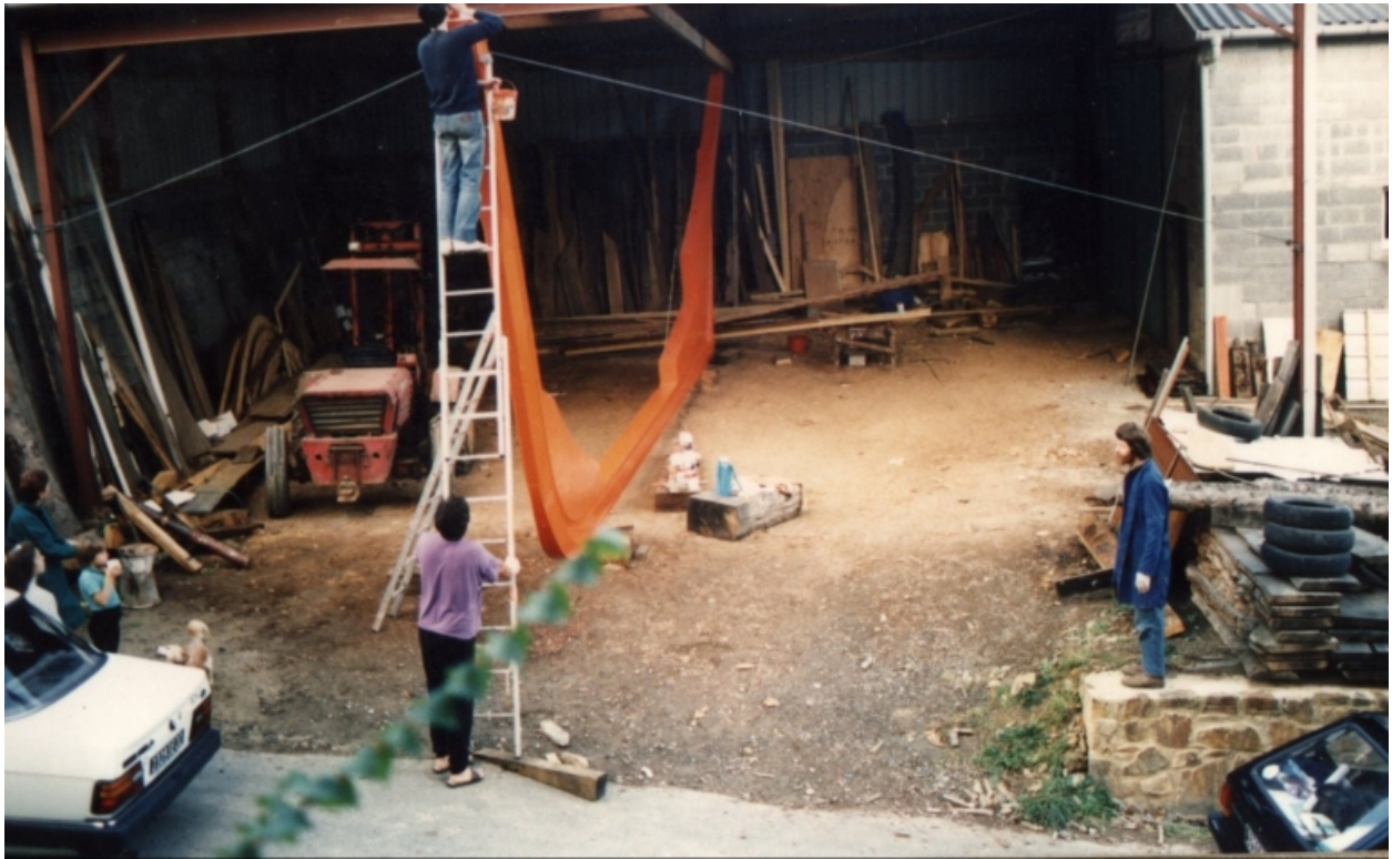
Vue de la charpente axiale en cours de montage au chantier Clochet en 1989 (collection particulière, Association le Grand Léjon)
