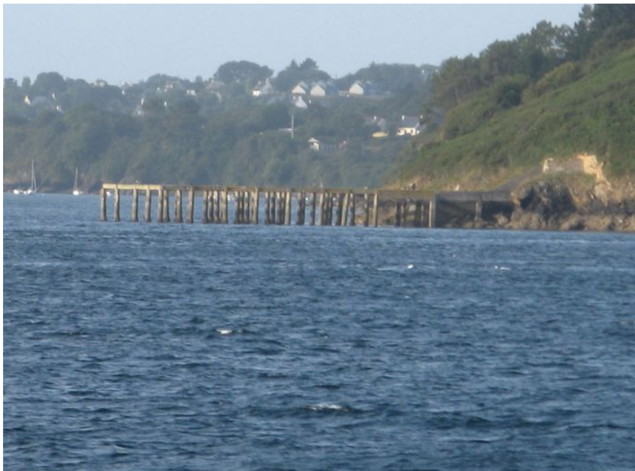
Vue générale de l'appontement de la pointe des Espagnols
