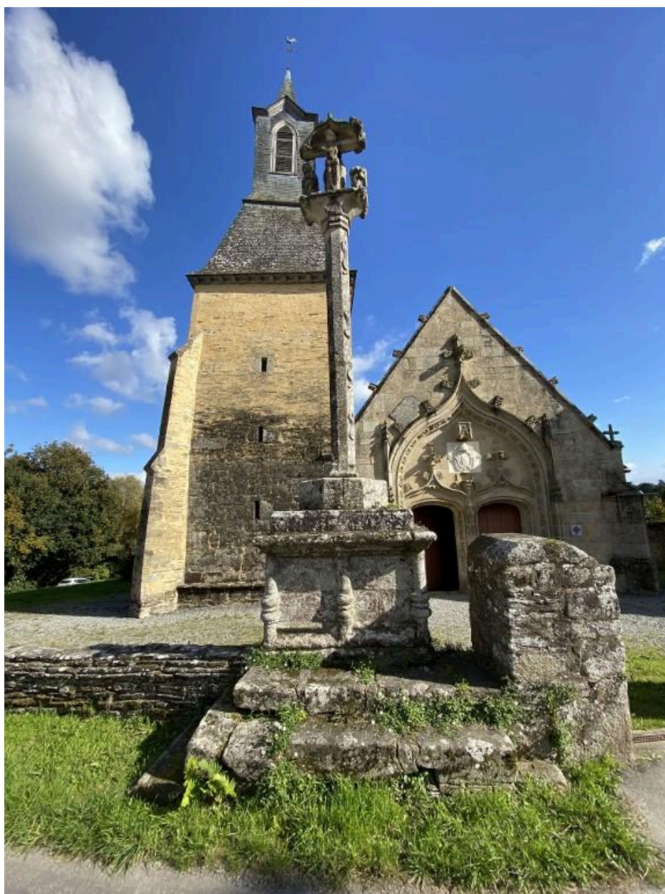
Face sud, vue générale
