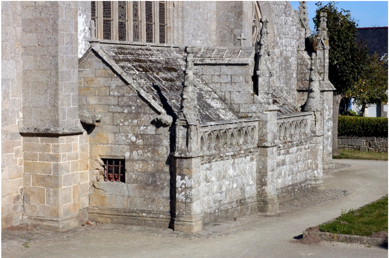
Vue biaisée de la sacristie-chambre du trésor
