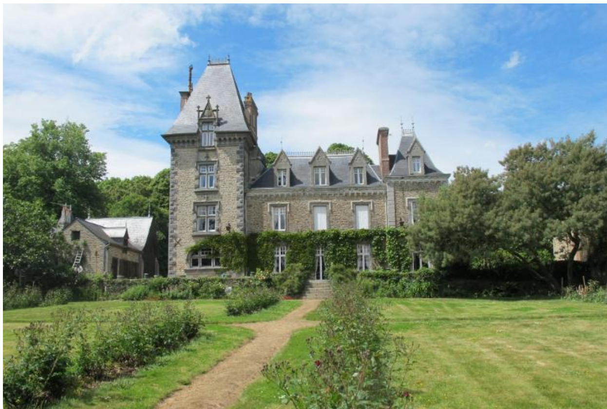
Façade arrière, vue générale
