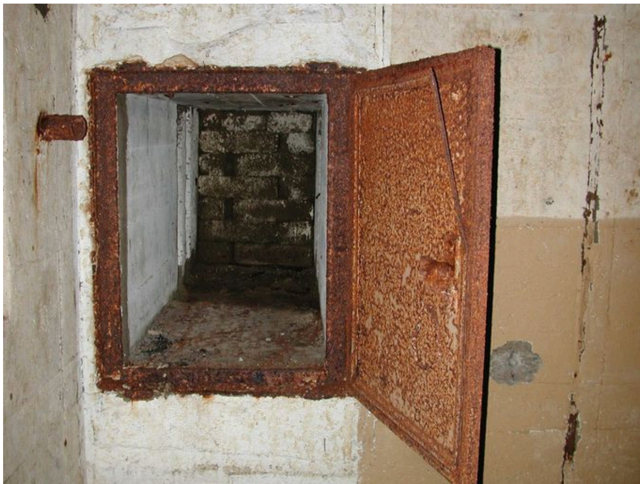
Vue de la pièce de vie - chambre de troupe : sortie de secours ayant conservé sa porte blindée et son mur en brique fermant le puits (état en 2003)
